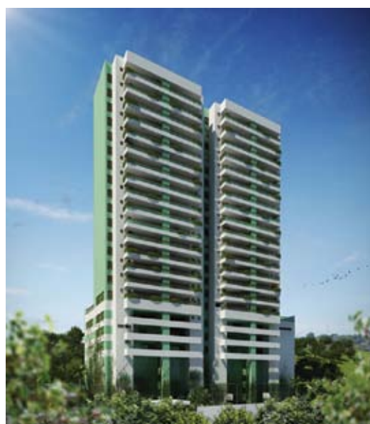
Figura 2 - Biarritz Maison Patamares Fonte: Concreta (Obra Biarritz Maison Patamares)
