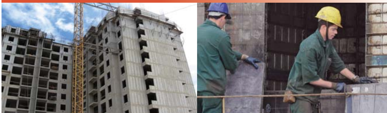
Figura 2 - Paredes de concreto - Fonte: Acervo ABCP
