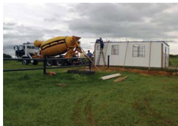
Figura 3 - Concretagem - Fonte: Global Housing
