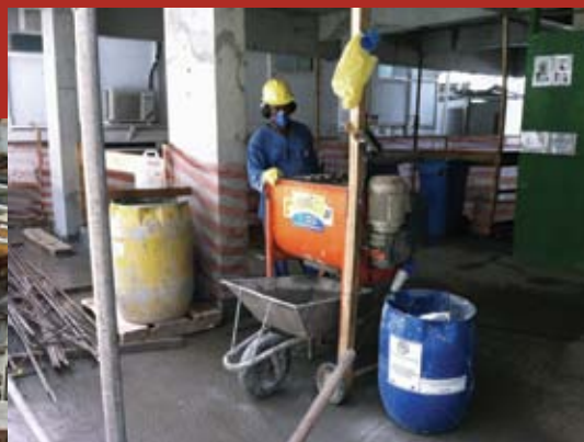
Figura 9 - Reutilização da água da betoneira durante a produção de argamassa Fonte: Acervo Sinduscon-Ba
