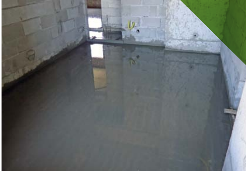
Figura 1 - Contrapiso auto-nivelante Fonte: Concreta (Obra Biarritz Maison Patamares)
