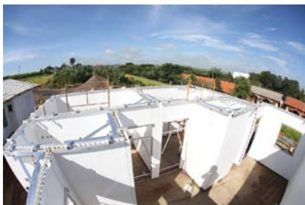
Figura 2 - Travamento em alumínio - Fonte: Global Housing
