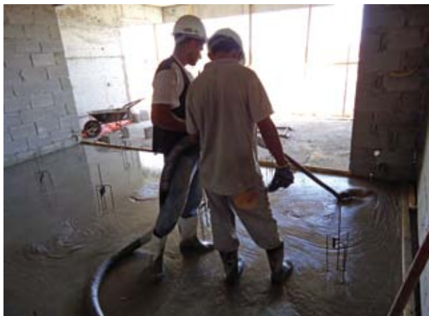
Figura 6 - Lançamento da argamassa Fonte: Concreta (Obra Biarritz Maison Patamares)
