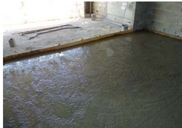
Figura 3 - Limpeza e preparo da área Fonte: Concreta (Obra Biarritz Maison Patamares)
